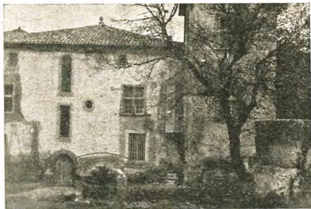
Château de la Bezole Façade Sud — Fenêtre et Porte au créneau
