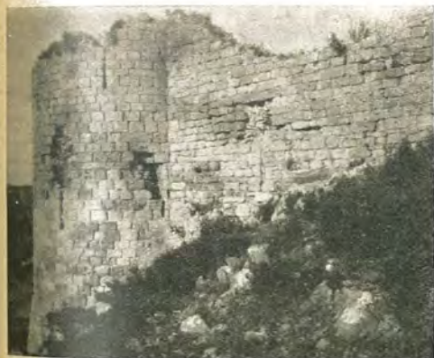
Tour ronde (Vue de l'Extérieur)
