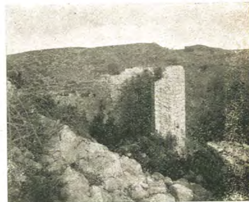
Tour ronde (Vue de l'Intérieur)
