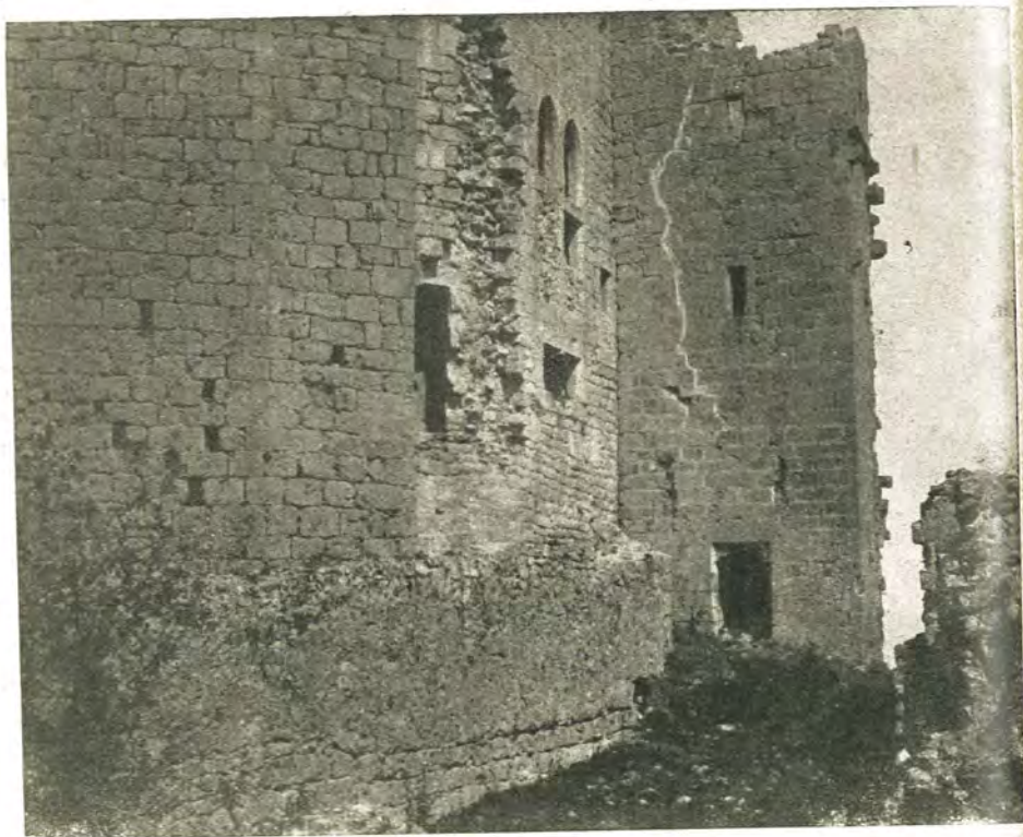
Donjon (Vue extérieure vers le midi) Porte et Tour de l'Escalier
